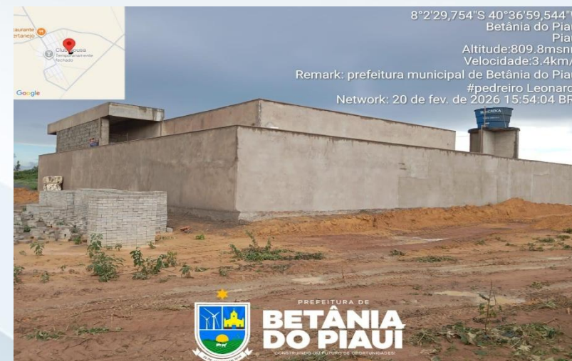
Figura 34: Execução de Obra da Unidade Básica de Saúde da Vila do Mel (Serra do Inácio)
